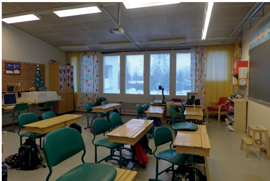
Opetustilan etelävisun ikkunat on uusittu puu-alumiini-ikkunoiksi. Luokissa on säilyneet myös opettajien korokkeet. LA
