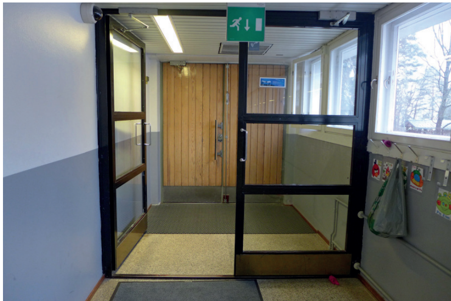
Käytävän uusitut tuulikaapin ovet ja ulko-ovet. LA
