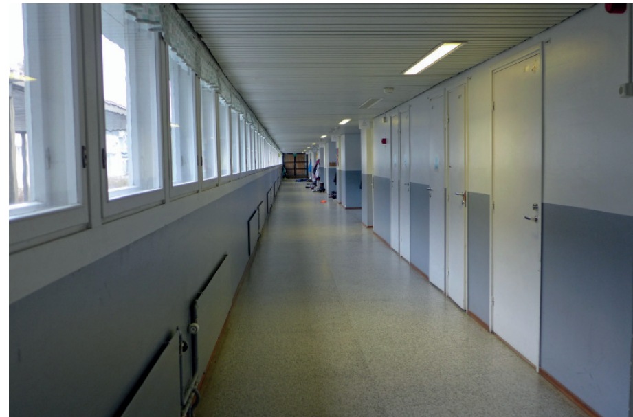
Luokkasiiven käytävä aulaista itään päin. Käytävässä on säilynyt alkuperäiset puuikkunat. Ensimmäisenä oikealla jälkikäteen rakennetut wc-tilat. LA
