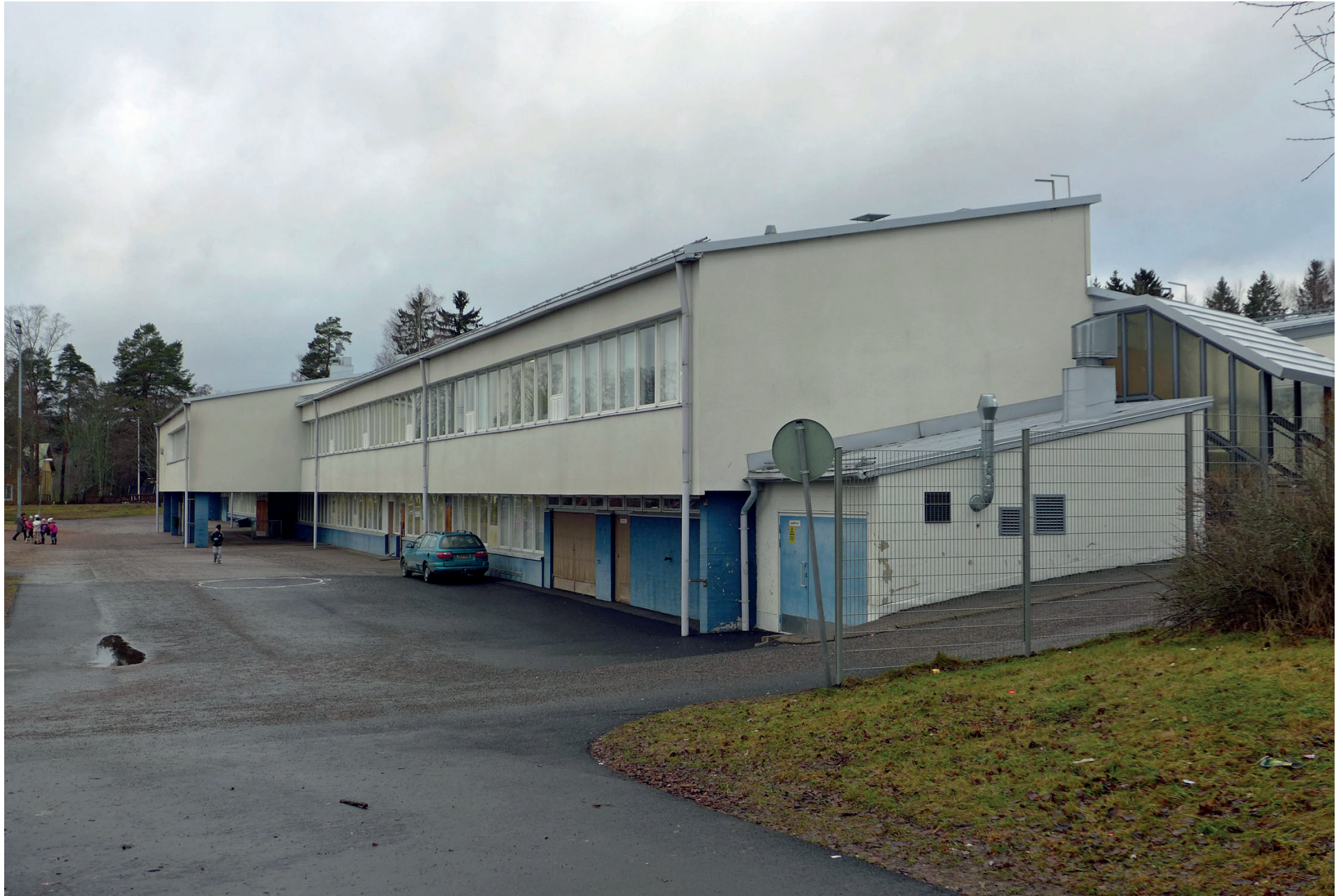
Luokkasiipi kuvattuna idästä päin, rakennuksen päädyssä purunpoistotila 2014. LA
