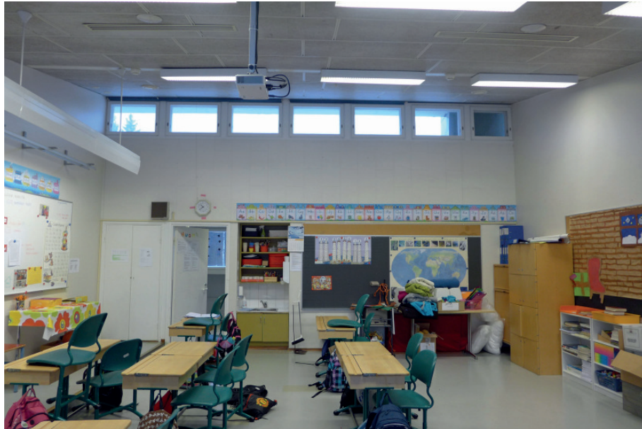
Luokkasiiven opetustila, Pohjoisvisun ikkunat ovat alkuperäisiä puuikkunoita. LA
