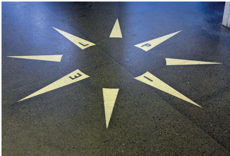
Portaiden yläpäässä on mosaiikkibetonilattiaan valettu kompassikuvio (1.kerroksessa). LA
