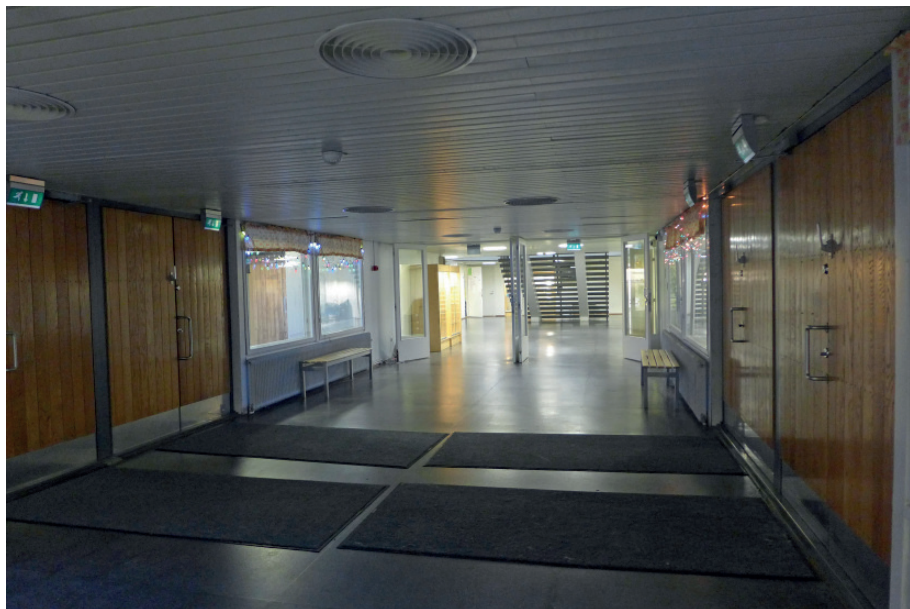
1. kerroksen tuulikaappi. Tilassa on alkuperäiset ikkunat. LA
