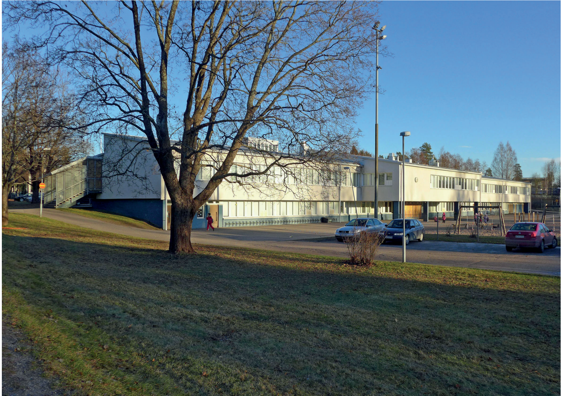
Eteläjulkisivu kuvattuna Kirkkotieltä päin 2013. LA
