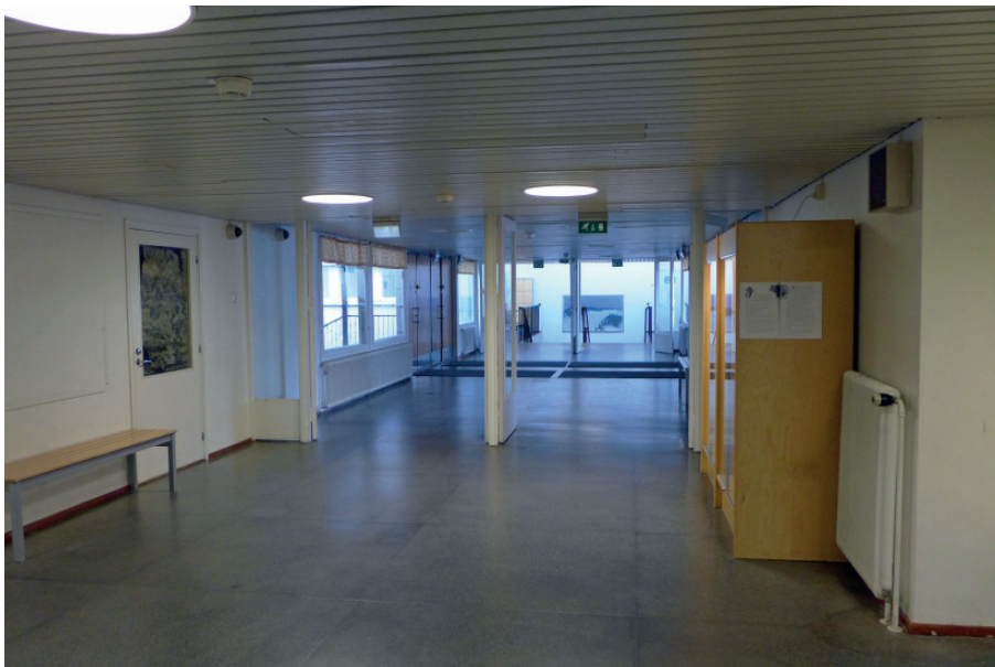
Näkymä aulasta tuulikaappiin ja luokkasiipeen päin. LA
